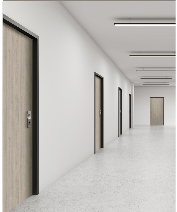
Nach der Sanierung mit unseren RC2 Türen
