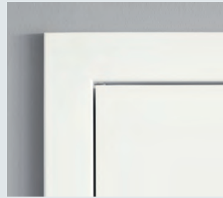
VarioFix Zarge ohne sichtbare Gehrung
